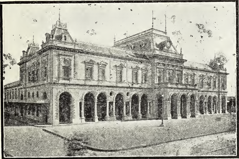
Montevideo: Estación Central de Ferrocarriles
